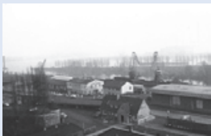
Bauarbeiten bei Dachser Neuss im Jahre 1969
