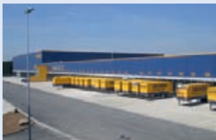
Der Neubau der Dachser-Niederlassung in Hof
